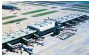
2단계 건설 (2002~2008) 탑승동 및 제3활주로 건설
